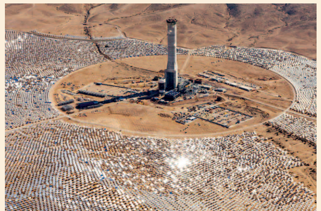
Sonnenergieanlage der Negev-Wüste; im Zentrum ein 250 m hoher Solarturm PHOTO: HELIOSCSP.COM
